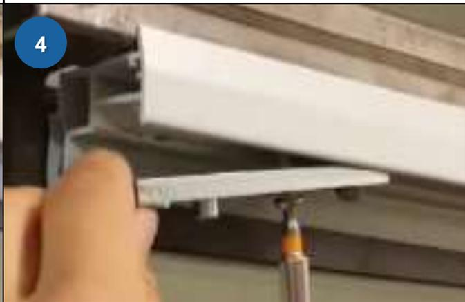
Wenn der Anschlagstift ausgetauscht ist, setzen Sie die Scharnierplatte in ihre ursprüngliche Position zurück, indem Sie zuerst die nächstgelegene Schraube festziehen.
