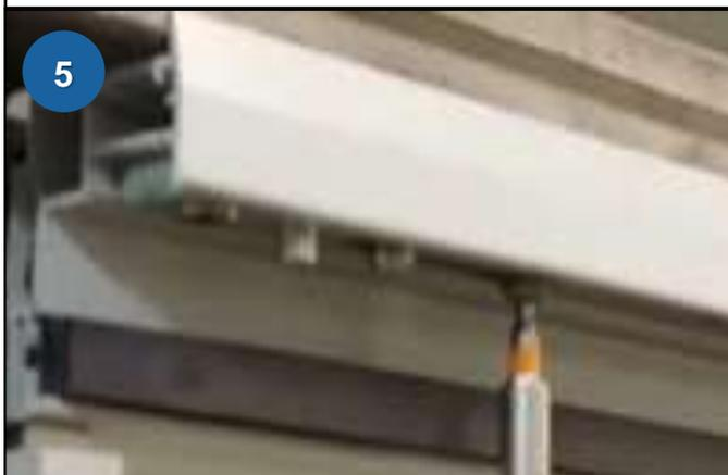
Ziehen Sie die zweite Schraube an der Scharnierplatte fest. Falls erforderlich, justieren Sie die Scharnierplatte in seitlicher Position.
