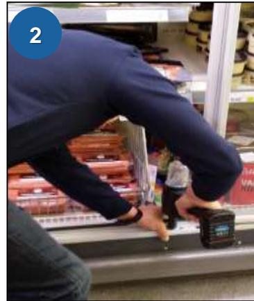
Wenn die Türen eingestellt sind und automatisch durch die Schwerkraft geschlossen werden, befestigen Sie den Rahmen mit **3 Alu-Nieten(Ø4, 8×25)**, die durch die vorgesehenen Löcher im Rahmen eingelegt werden. Schließen Sie das Unterteil mit der mitgelieferten Abdeckung, wenn die Niete eingesetzt sind
