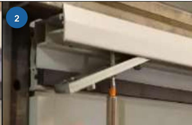
Lösen Sie die nächstgelegene Schraube, um den Stift zu stoppen. Diese kann bei Bedarf entfernt werden.
