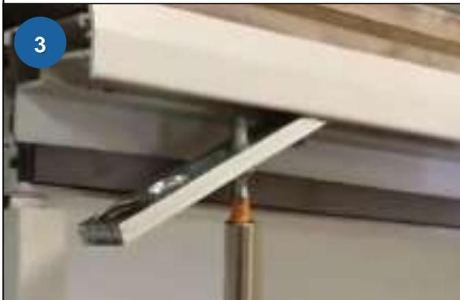
Wenn die Scharnierplatte in der ersten Schraube geneigt hängt, können Sie den Anschlagstift leicht entfernen und durch eine neue kürzere/längere Version ersetzen.
